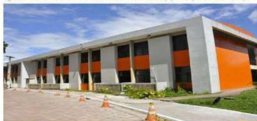
Figura 1 – Prédio modular de sala de aula e auditório na Unidade Tapajós, Campus de Santarém, Ufopa
